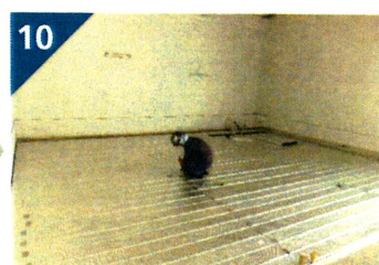
床板組み立て
