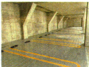
(屋内スマートデッキ)
