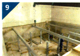
鉄骨組み立て
